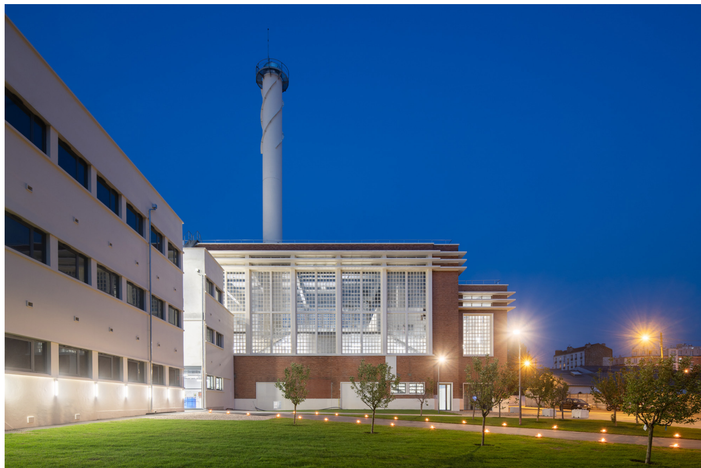
Vue de la Chaufferie - Fondation Fiminco © Martin Argyroglo
